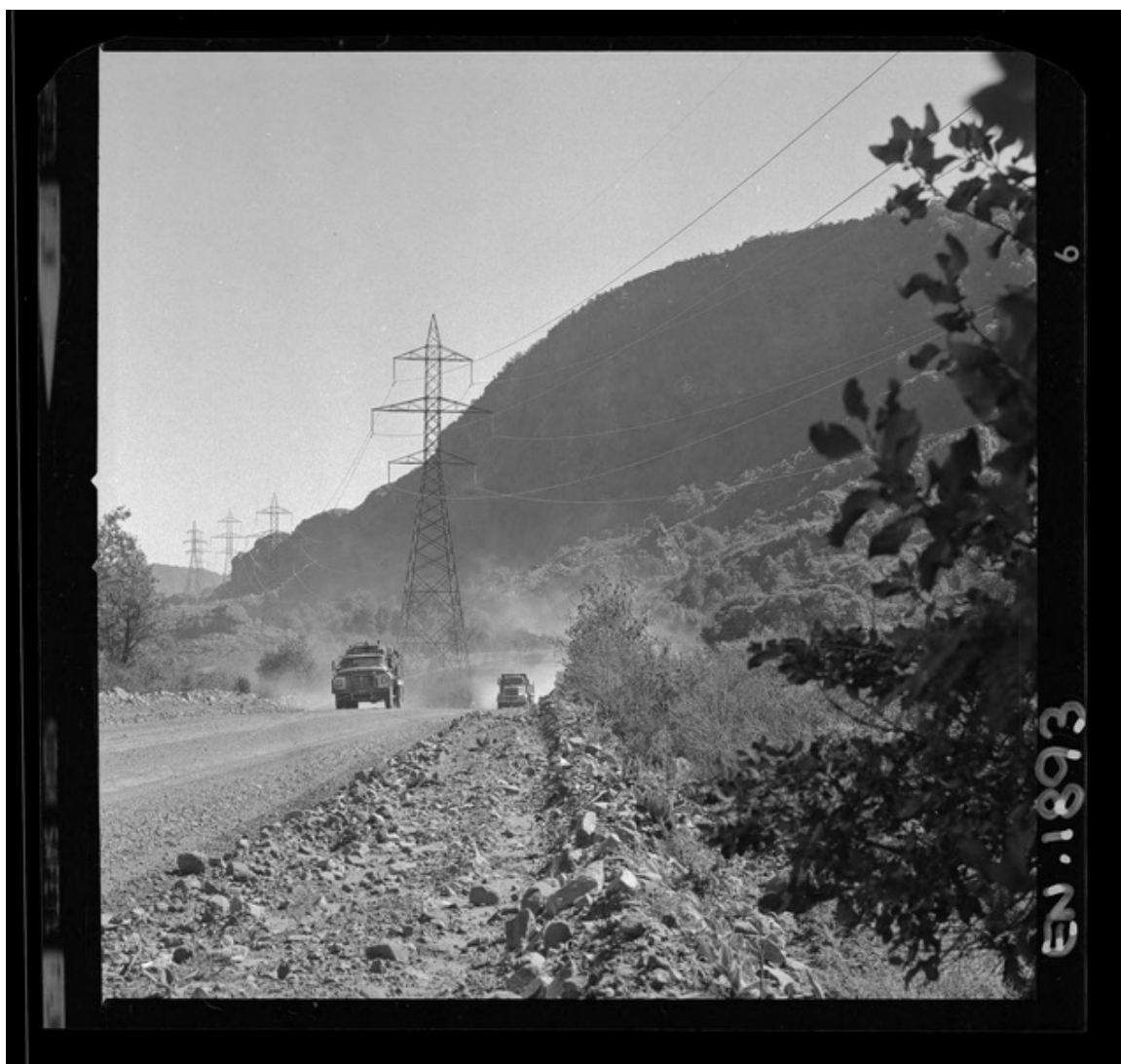
[Casa de máquinas en una segunda etapa : Torres de conducción, zona de Antuco] [fotografía] Luis Ladrón de Guevara.
