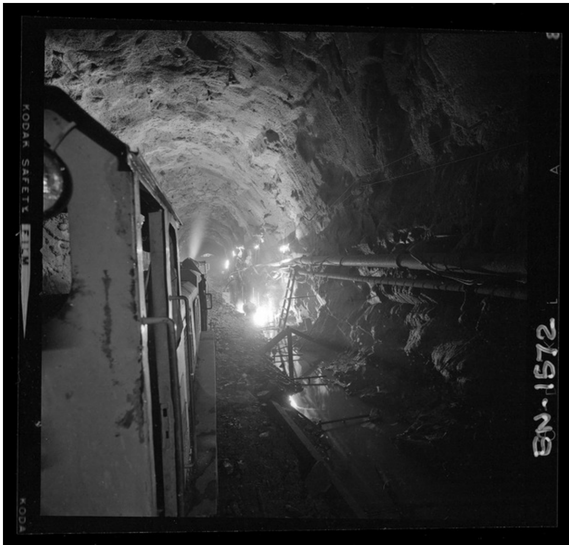
Aspecto de túneles en etapa de terminación, uso de moldajes retráctiles y hormigonado de bóveda [fotografía] Luis Ladrón de Guevara.
