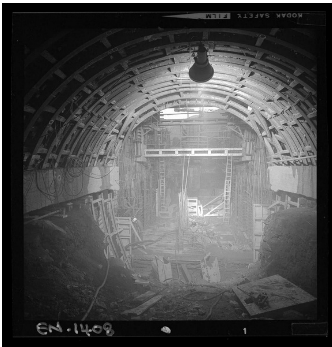
Refuerzos de la obra de toma, entrada del túnel común de aducción y faena de hormigonado de solera del mismo
