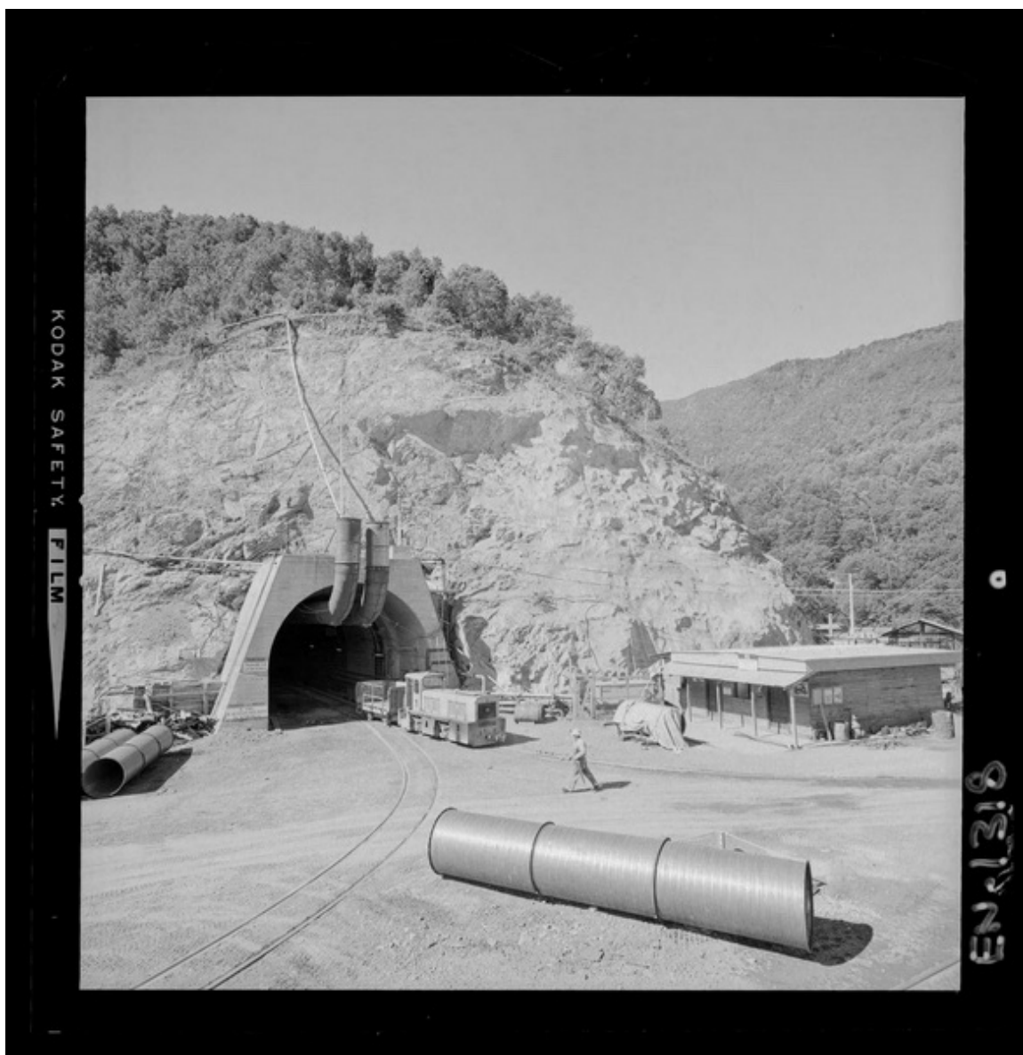
Refuerzos de la obra de toma, entrada del túnel común de aducción y faena de hormigonado de solera del mismo. [fotografía] Luis Ladrón de Guevara.
