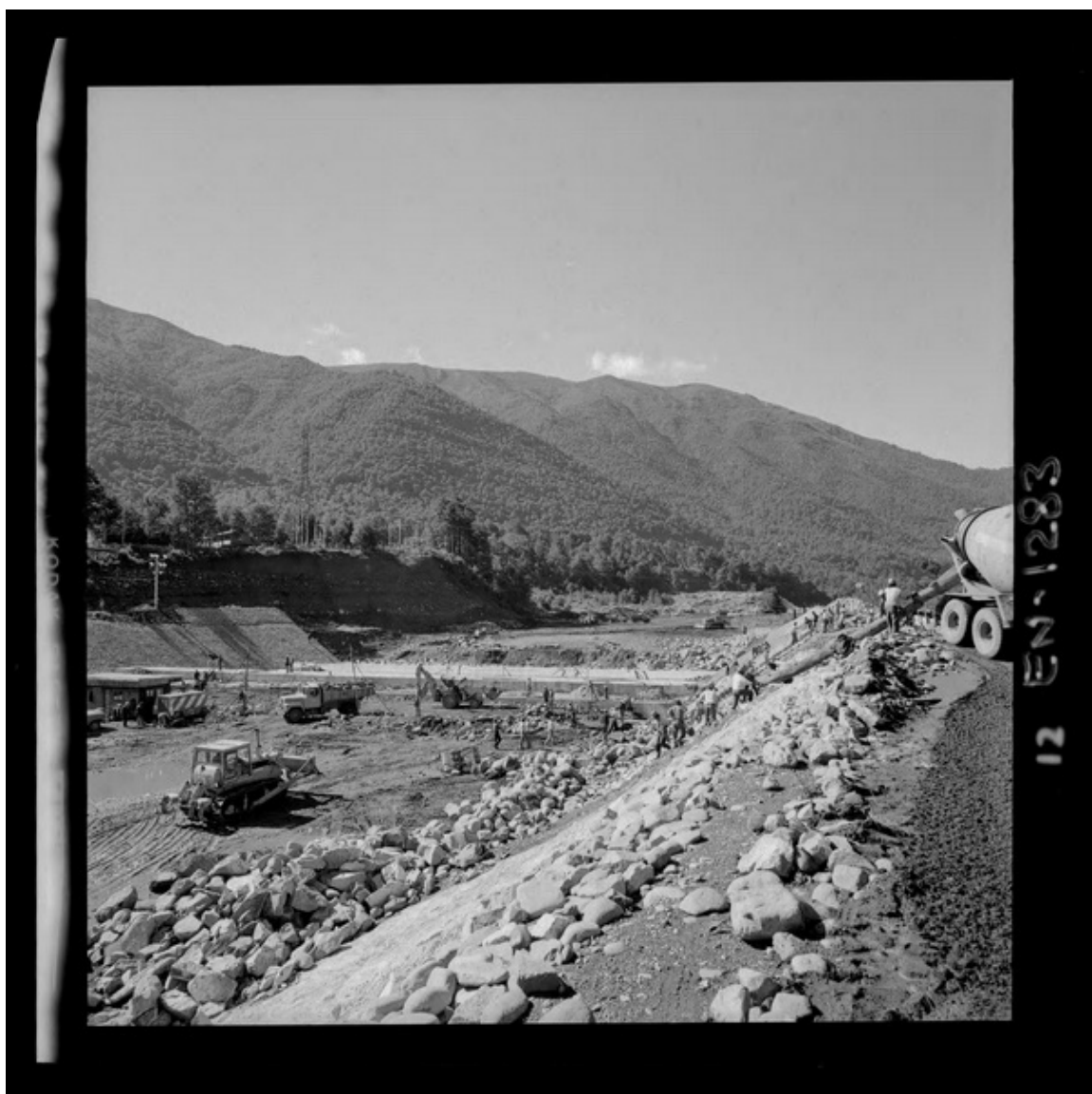
Faenas de excavación y revestimientos del canal de desviación del río Polcura, vista hacia aguas abajo. [fotografía] Luis Ladrón de Guevara.
