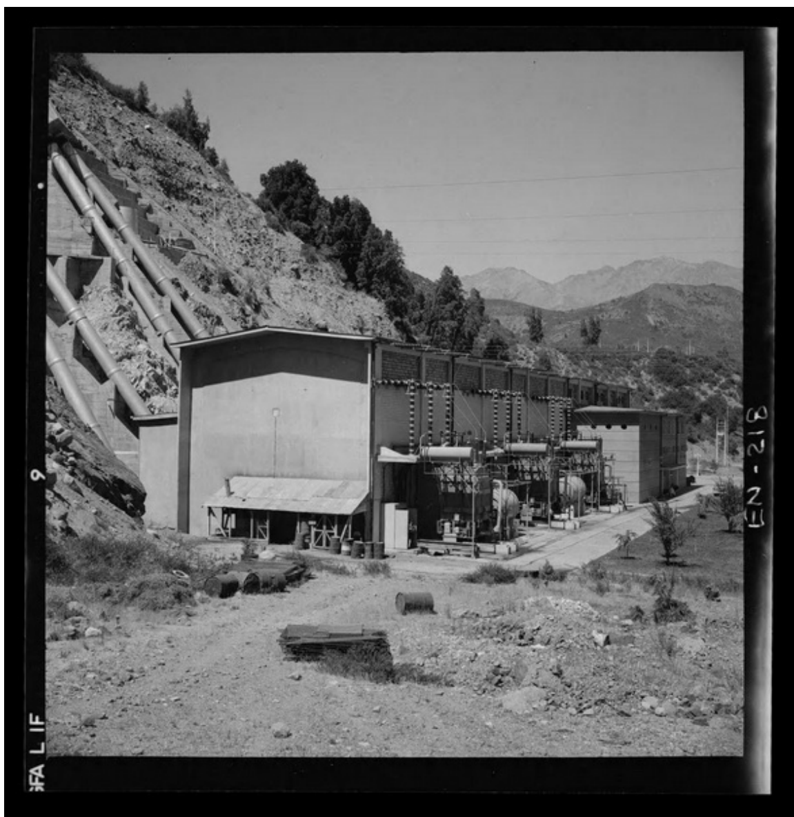
Detalles del edificio de la Central "Cipreses", patio de transformadores [fotografía] Luis Ladrón de Guevara.
