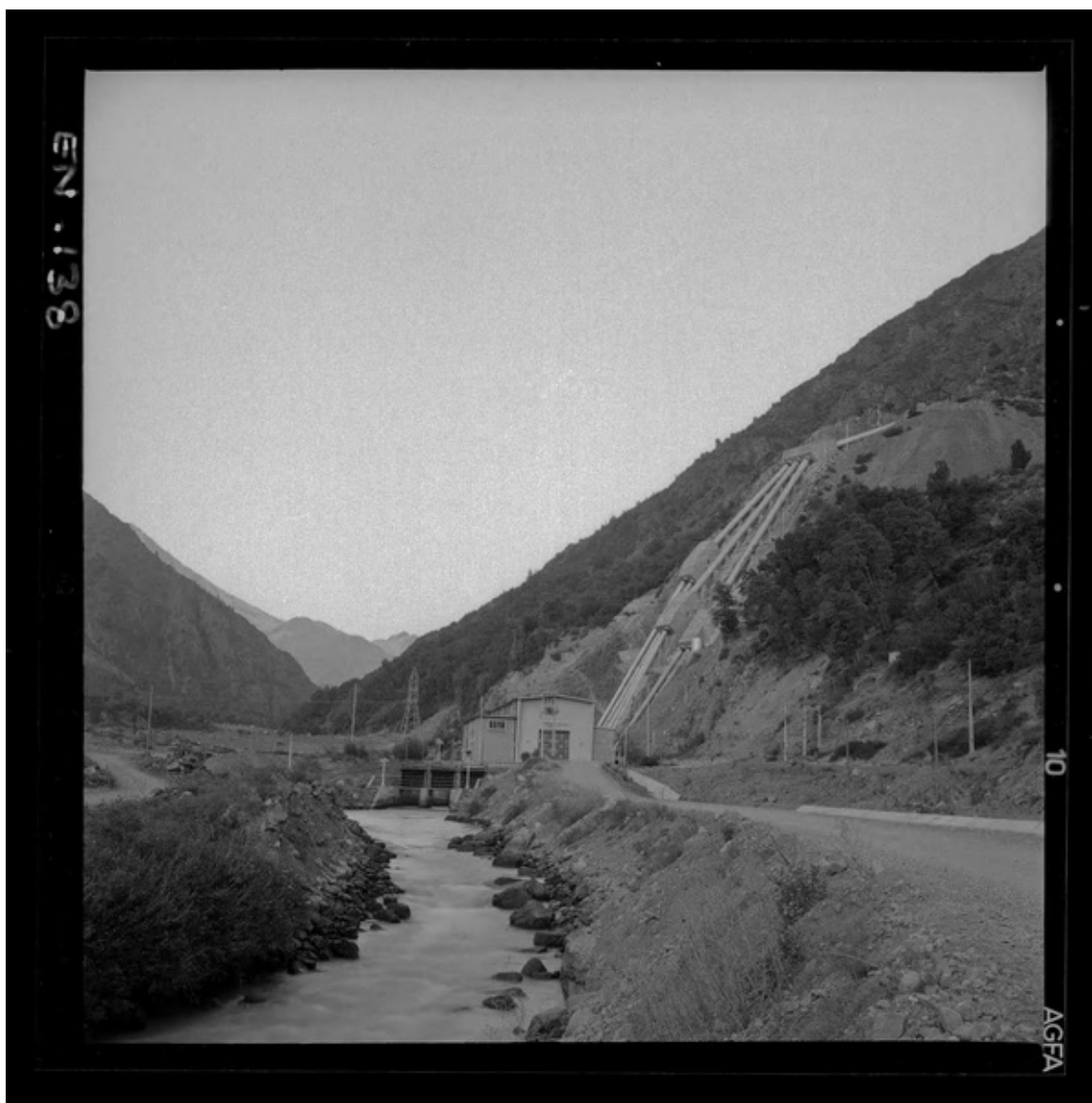
Vista general desde el canal de evacuación [fotografía] Luis Ladrón de Guevara.
