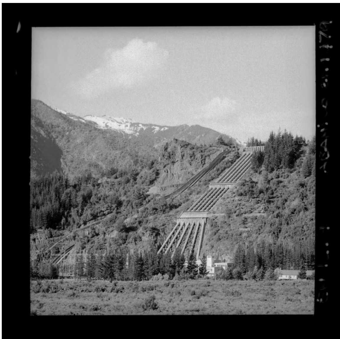
[Vista general, Central Hidroeléctrica "Abanico"] [fotografía] Luis Ladrón de Guevara.
