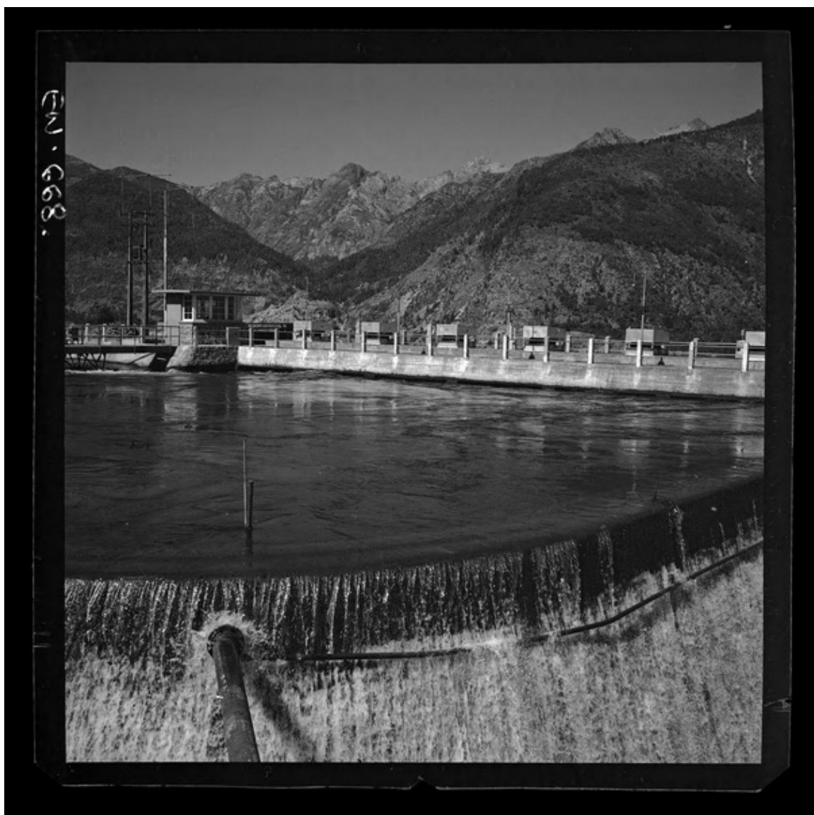
Cámara de carga [fotografía] Luis Ladrón de Guevara.
