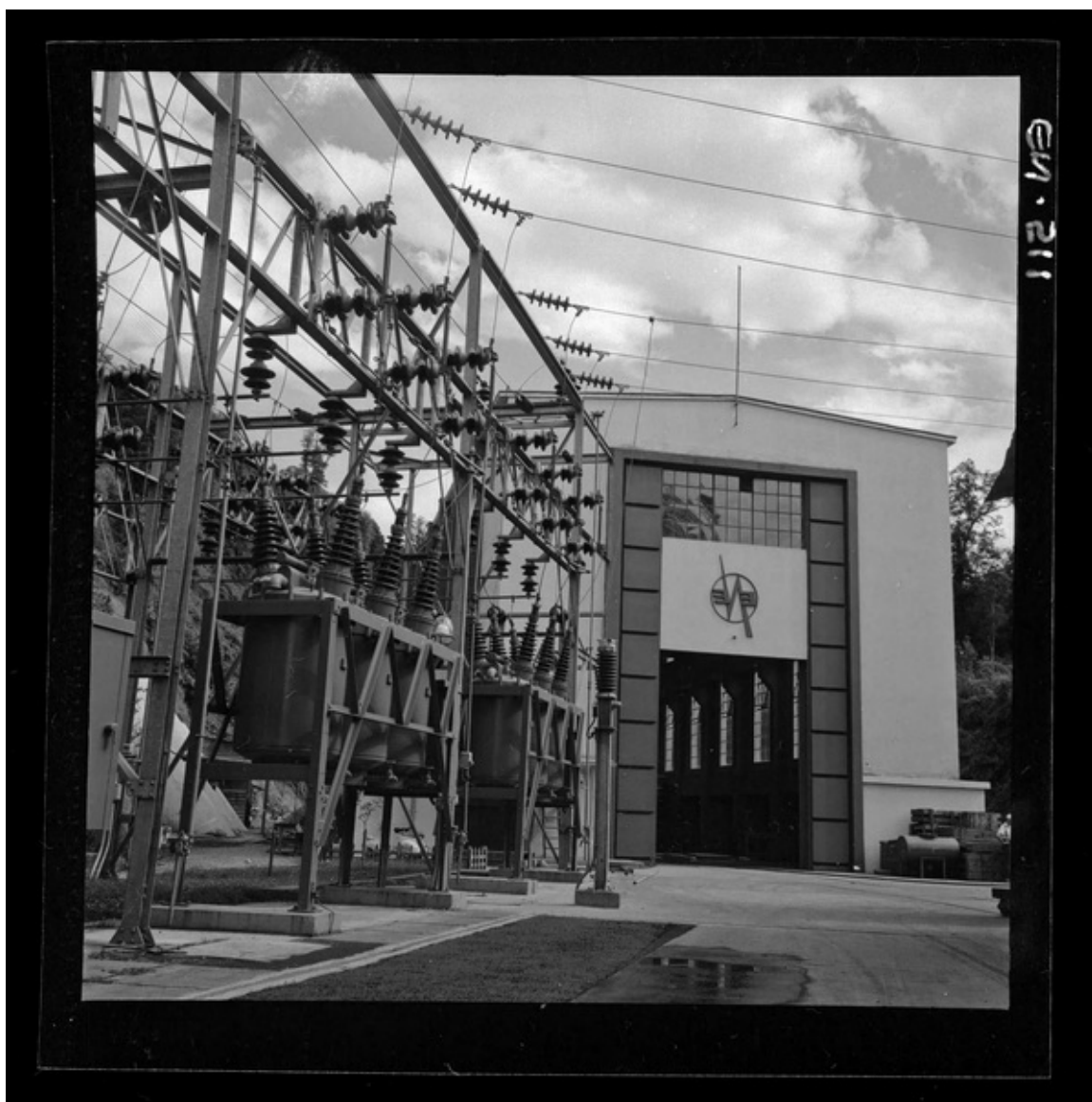
[Edificio de la Empresa Nacional de Electricidad S.A. "Endesa"] [fotografía] Luis Ladrón de Guevara.
