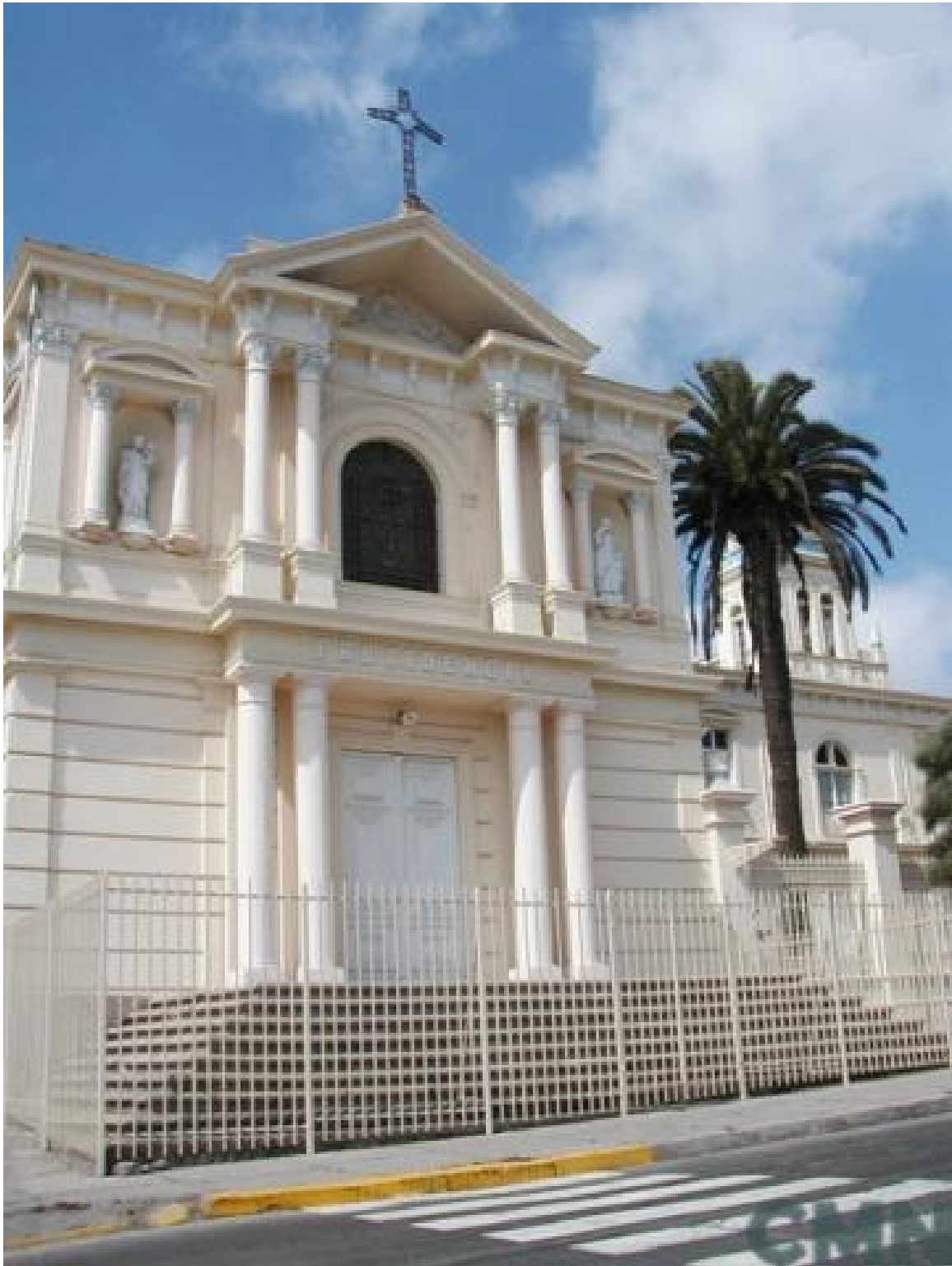
Capilla de la Casa de la Providencia, Casa de la Providencia, claustro y dependencias que la conforman
