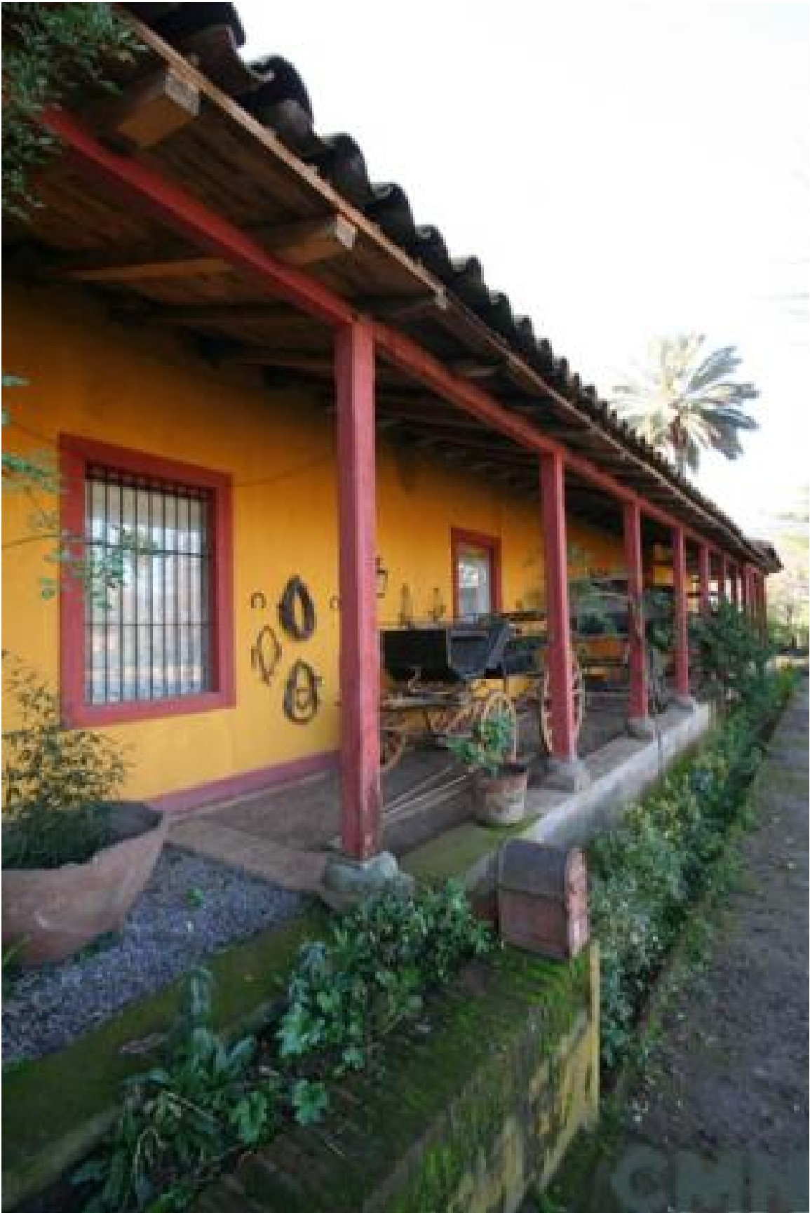
Casona de la Hacienda Alhué y predio que la circunda
